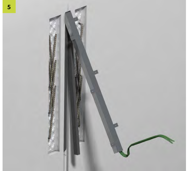
5 Nach dem ersten Betonierabschnitt die Verwehrkästen der FERBOX® Rückbiegeanschlüsse, die Verwehrboxen der PENTAFLEX® Module sowie die EPP-Füllstreifen entfernen
