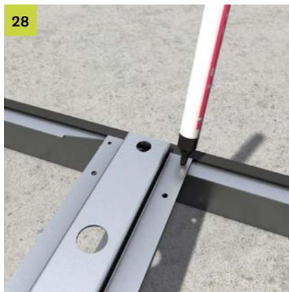
Bei dem geschnittenen Kanalabschnitt müssen die fehlenden Befestigungslöcher für die Traverse mit dem Durchmesser 6 mm nachgebohrt werden. Hierfür kann die Traverse als Bohrschablone genutzt werden. Zwischen zwei Kanalabschnitten ist stets eine Traverse zu setzen.
