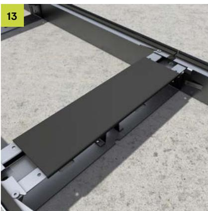
Das Trittschallprofil wird mittig auf die Traverse geklemmt. Die Bohrlöcher zur Befestigung der Deckel dürfen nicht verdeckt werden.
