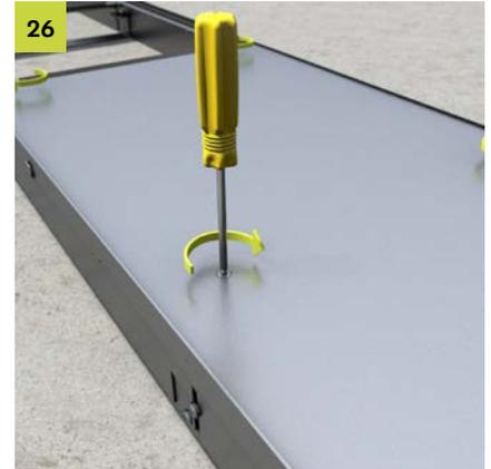
Blinddeckel auf dem Kanal ausrichten und mittels Schrauben von oben sichern.
