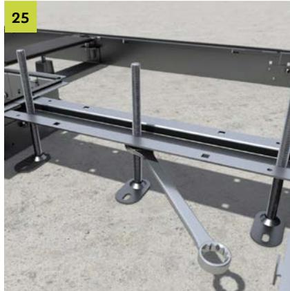
Nivellierfüße mittels Kontermuttern gegen Lösen sichern und mittels geeignetem Werkzeug auf das Niveau der Traversenoberfläche kürzen.
