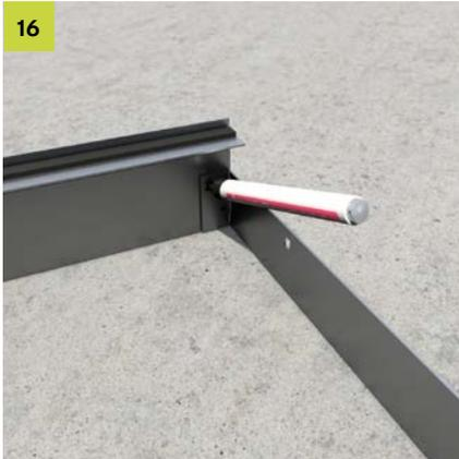
Wenn der Kanal geschnitten wurde und das Endstück gesetzt werden soll, muss das Unterteil des Endblechs genutzt werden, um die Verbindungslöcher ( $\varnothing 7$  mm) korrekt zu positionieren.
