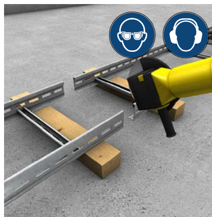
Abb. 2: Arbeitsschutzmaßnahmen bei Schneid- und Trennarbeiten beachten
