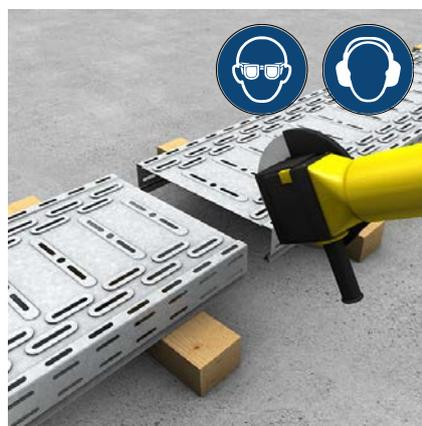
Abb. 2: Arbeitsschutzmaßnahmen bei Schneid- und Trennarbeiten beachten.
