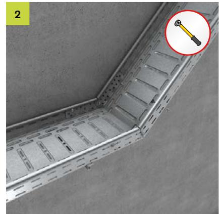
Anschließend 2x RGV je Seitenholm in den V-Schnitt einschieben und den gewünschten Winkel vorsichtig biegen. RGV an den Enden mittig verschrauben. Der Gelenkpunkt wird mit M8 bzw. M6 bei RGV 35 ausgeführt.
