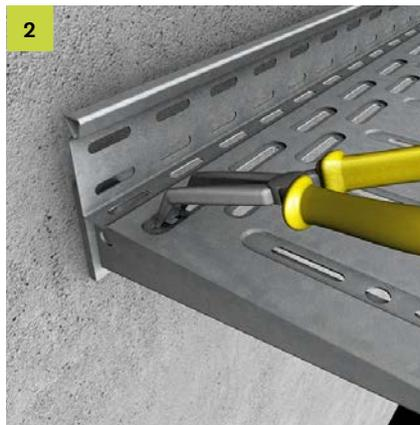
Zur Demontage KLF an der Spitze mit einer Zange zusammendrücken und herauschieben.
