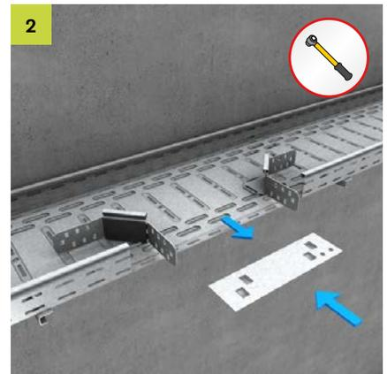
RAE in die Kabelrinne einschieben und je Holmseite und im Boden verschrauben. Bodenverbinder (VB) aufsetzen.
