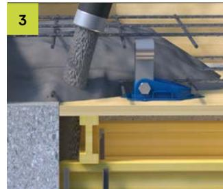
Betonieren der Liftschachtdecke.
