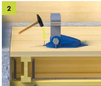
Festnageln des Ankers via Nagellöcher im Deckel.
