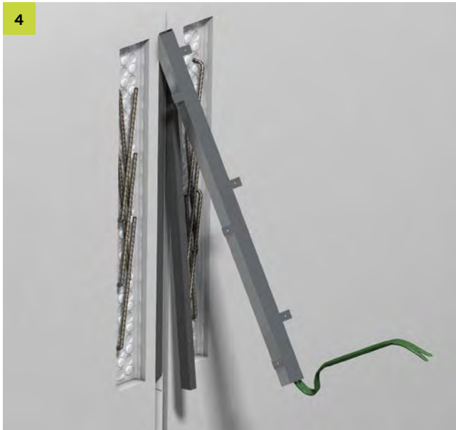
Nach dem ersten Betonierabschnitt die Verwahrkästen der FERBOX® Rückbiegeanschlüsse, die Verwahrboxen der PENTAFLEX® Module sowie die EPP-Füllstreifen entfernen.
