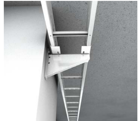
3 | Wandkonsole Schwere Wandkonsole (KWS) an Betonwand mit Holmstützen (WPHS-K) gedübelt.
