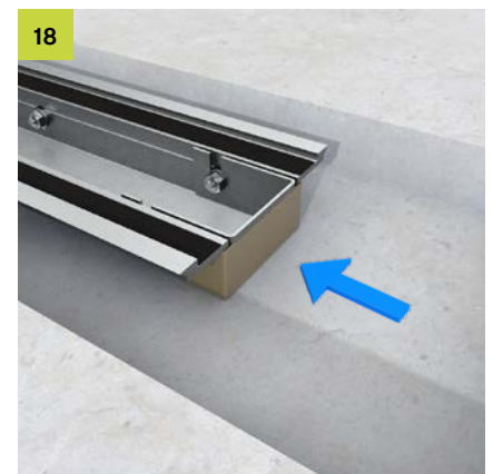
Alle offenen Stellen abkleben und die Blinddeckel erst nach Estricheinbringung einlegen.
