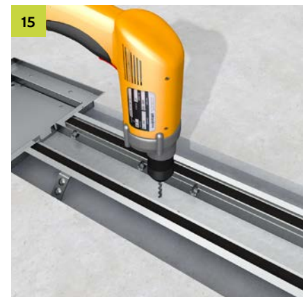
Kanal 3x pro Länge auf der Rohbetondecke mittels Dübel (SNA 6x30/5) fixieren.
