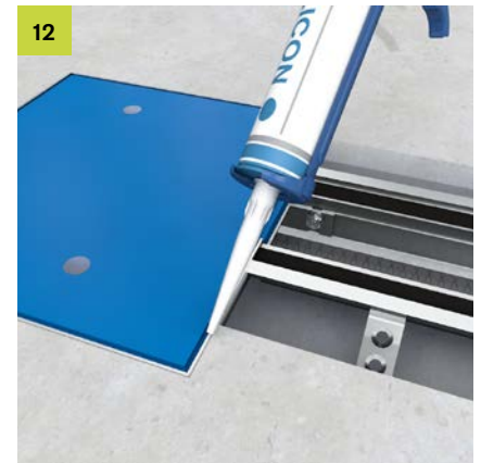
Abschließend erfolgt die Verfungung des abgestuften Deckelrandes mit geeigneter Dichtungsmasse.
