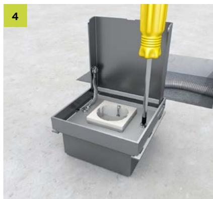
4 Die Abdeckplatte und die Erdungsleitung vom Rahmen der Bodensteckdose lösen.
