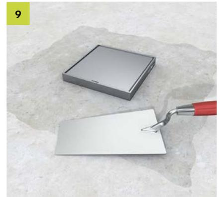
Vor Einbringen des Mörtels ist die Position der Bodensteckdose zu prüfen. Den Mörtel ohne Lufteinschlüsse einbringen, bei Bedarf den Spalt zwischen Rahmen und Deckel abkleben.
