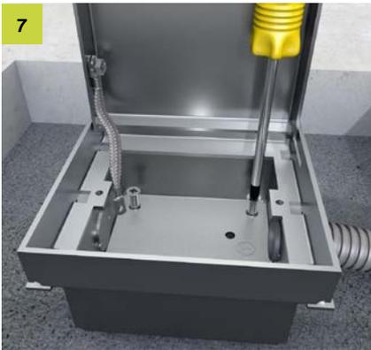
Die waagerechte Ausrichtung und Höhenverstellung der Bodensteckdose erfolgt über die vier Stellschrauben. Bei Bedarf kann die Bodensteckdose auf dem Unterboden fixiert werden.
