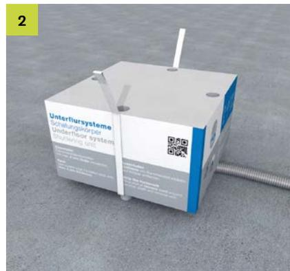
2 Leerrohre am ausgerichteten Schalungskörper fixieren. Vor Einbringen des Estrichs den Schalungskörper auf dem Rohboden befestigen und so gegen Aufschwimmen sichern.
