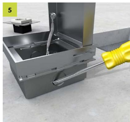
5 Perforation an den Seitenwänden der Bodensteckdose entfernen und Leerrohr einführen.
