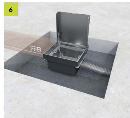
6 Die Bodensteckdose in den Hohlraum einsetzen. Es ist sicherzustellen, dass die Bodensteckdose auf Fertigfußbodenhöhe ausgerichtet ist.
