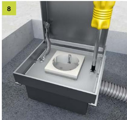
Nach dem Anschluss der Steckdose wird die Abdeckplatte über die Schrauben wieder am Rahmen der Bodensteckdose fixiert. Potentialausgleich beachten.
