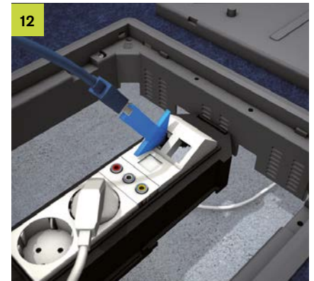
12 Datenaufnahme Nach vollständiger Bestückung des Gerätebeckers können die Patch-Kabel unter Beachtung des Biegeradius von 45° in die Datenaufnahme gesteckt werden.
