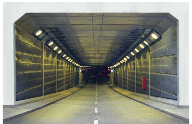
Tiergarten Tunnel (Berlin, Germany)
