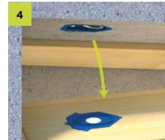
Beim Ausschalen der Decke wird der Deckel mitentfernt. Falls der Deckel am Gehäuse verbleibt, kann er über die Öffnung im Deckel abgezogen werden.
