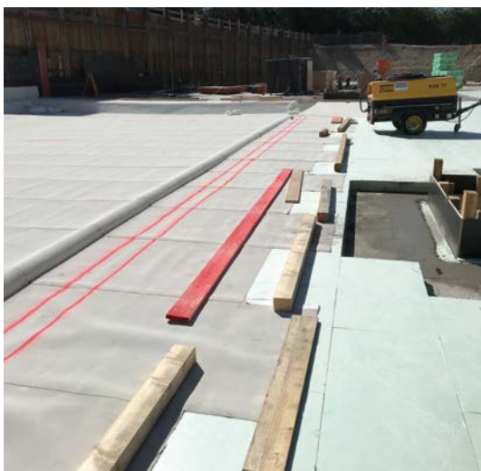
Unterlegholz zur Ablage von Bewehrung
