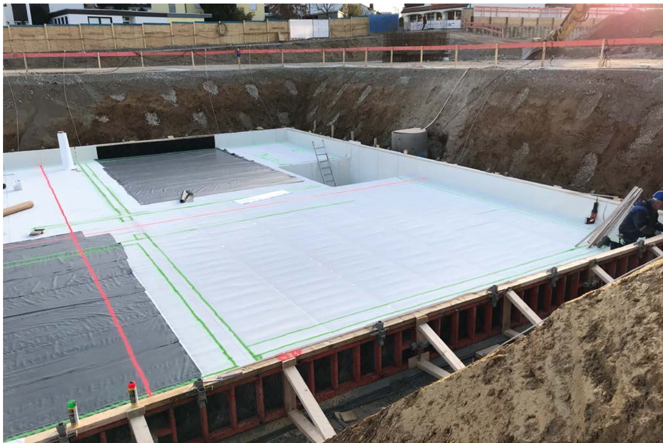
Verlegung unter Bodenplatte mit einlagiger PE-Folie
