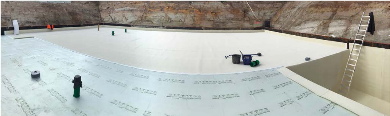
Sauber verlegte Fläche durch vorab sensibilisiertes Personal
