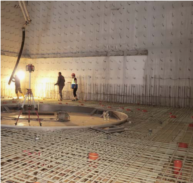
Bodenplatten-, Stützen- und Durchstanzbewehrung Fusionsreaktor-Forschungsanlage Tokamak in Prag, Tschechische Republik
