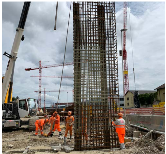
Schlitzwandbewehrung Autobahneinhausung Schwamendingen, Schweiz
