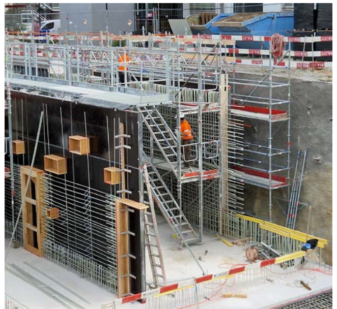
Bewehrung der Bodenplatte, Wände und Decke des Kryostaten- raums, Paul Scherrer Institut (PSI), Villigen, Schweiz
