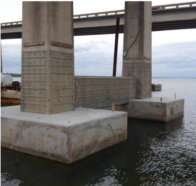
Sanierung von Brückenstützen im Salzwasser Florida, USA
