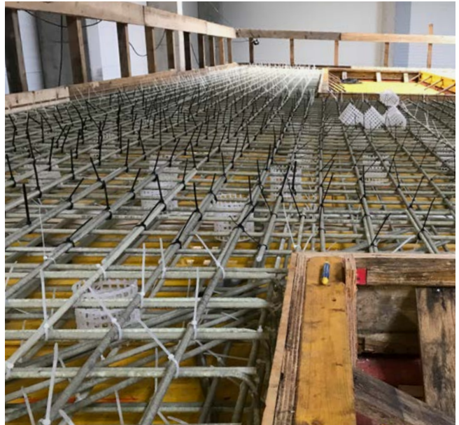
Deckenplattenbewehrung European XFEL GmbH Schenefeld, Deutschland
