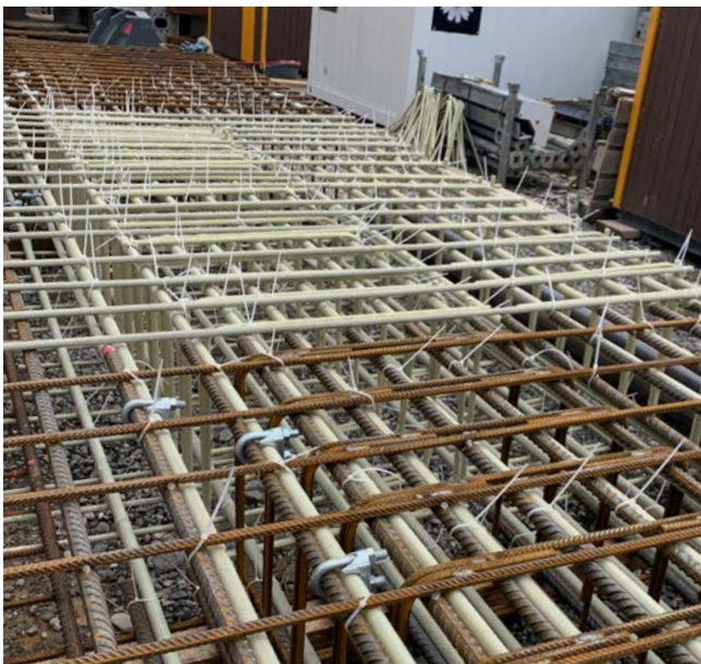
Schlitzwandbewehrung Autobahneinhausung Schwamendingen, Schweiz
