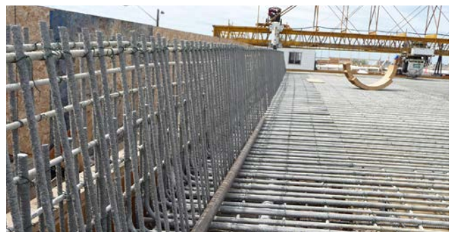
Einbau von FIBERNOX® V-ROD in Brückendeck und Betonleitplanken
