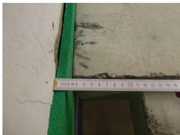
Abbildung 5: Fugendämmstoff SINTON® S zwischen der Wand und dem Podest bei einer Fugenbreite von 15 mm.
