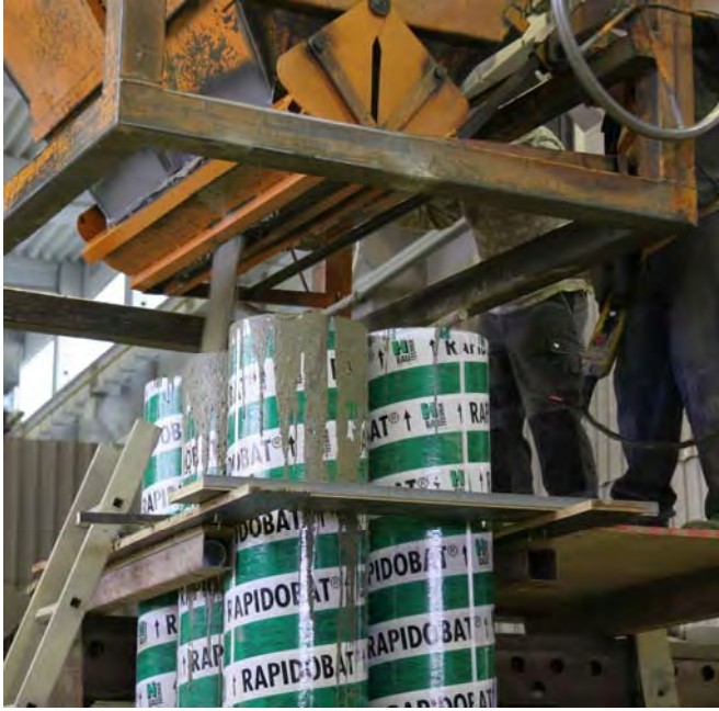
Abbildung 2: Befüllen der Stützen bei Betonage A.
