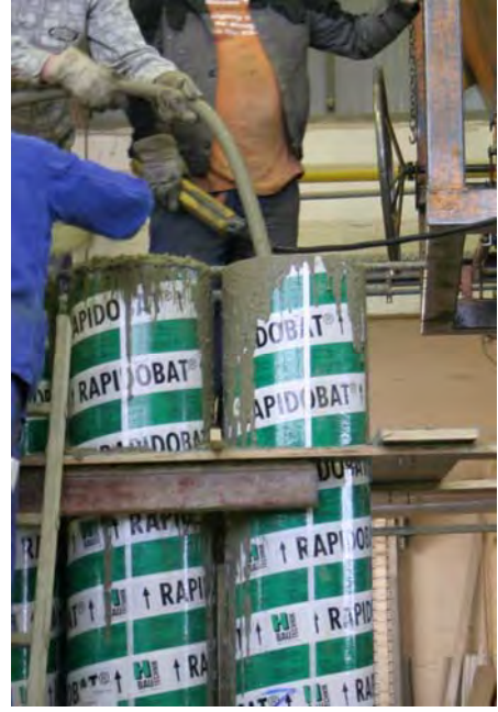
Abbildung 3: Verdichten des Betons mit einem Flaschenrüttler.
