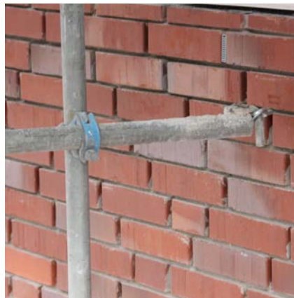
Befestigung des Arbeitsgerüsts am Gerüstanker über eine Gerüstöse
