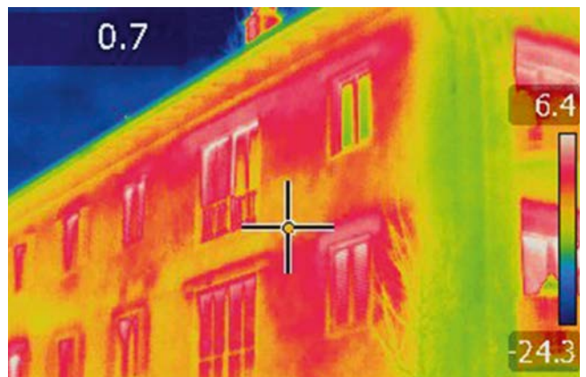
Visualisierung von Wärmebrücken mittels Thermografie
