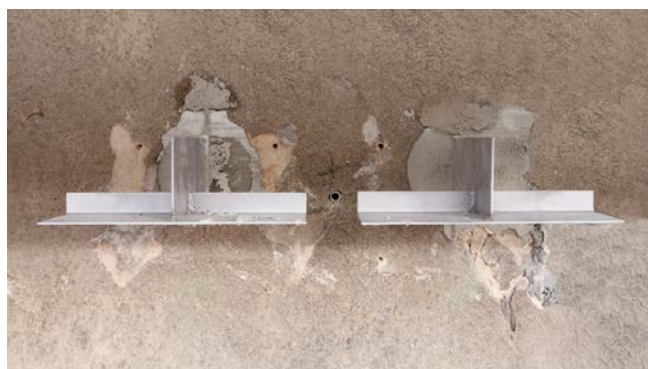
Bild oben: JMK+ P Konsole Montage
