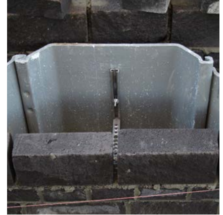
Anschluss von Verblendmauerwerk an Stahlbetonbauteile
