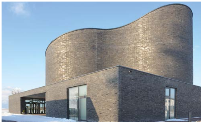
St.-Marien-Kirche zu Schillig: Eine besondere Herausforderung bildeten die geschwungenen Formen des Bauwerks, die bei der Konsolenplanung durch unsere Experten berücksichtigt wurden.
