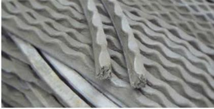
Schlangenförmiger Dreikant-Flächenabstandhalter mit geringer Aufstandsfläche aus Faserbeton für horizontale Matten- und Rundstahlbewehrung.
