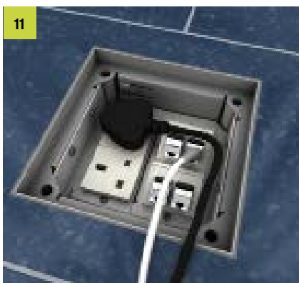
11 Bestückung Stark- und Schwachstromtechnik einstecken.
