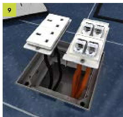
9 Installationsgeräte Steckdosen und Datentechnik in Platinen einrasten und Leitungen anschließen.
