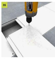
**Blinddeckelabschnitt**Zusätzliche Bohrlöcher erstellen und diese nachsenken.
