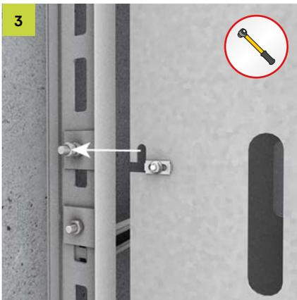
Den Anfahrerschutz (STDE) auf die vormontierten Sechskantschrauben (SES 10X50) einhängen und,
