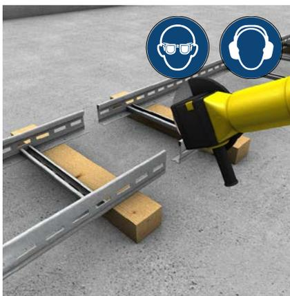
Abb. 1: Arbeitsschutzmaßnahmen bei Schneid- und Trennarbeiten beachten.
