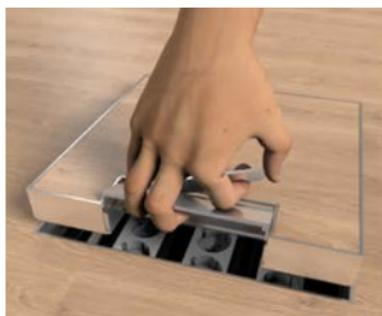
**2** | Leitungsauslassklappe hochklappen.
