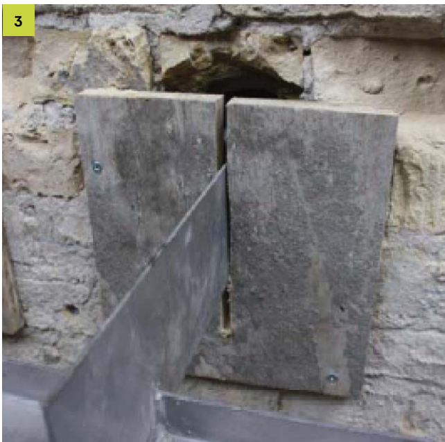
Konsole grob ausrichten (vertikal) – Schalbrett mit Schlitz befestigen. Roughly align console (vertically) and attach the slotted formwork board.
