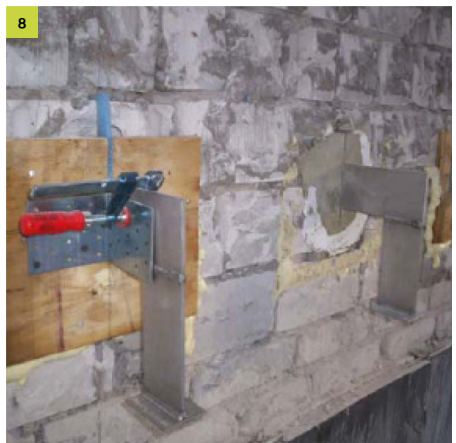
Mörtel aushärten lassen. Allow the mortar to harden.
