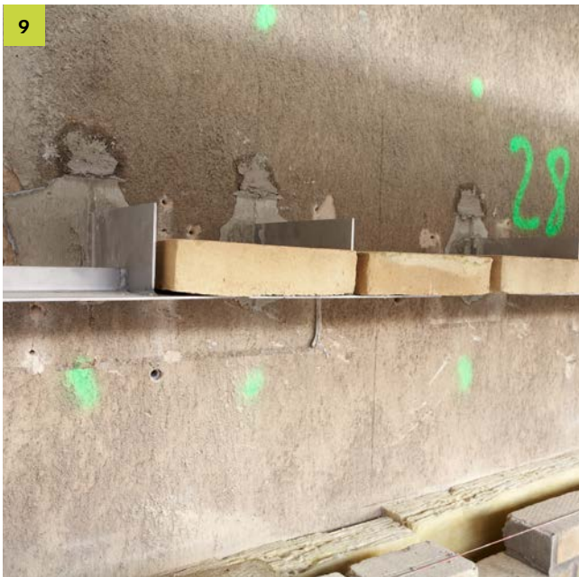
Schalbretter entfernen und Verblendschale herstellen. Remove formwork boards and create facing masonry.
