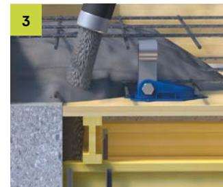
Betonieren der Liftschachtdecke.
