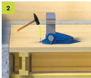
Festnageln des Ankers via Nagellöcher im Deckel.
