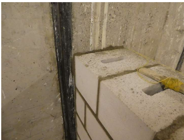
Abbildung 7: Detail des Mauerwerks.
