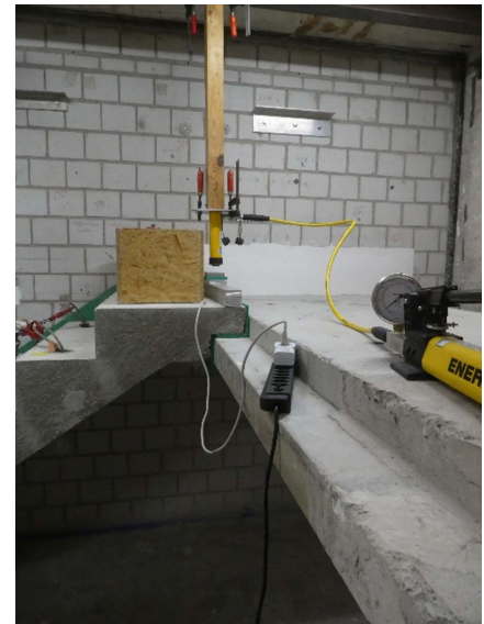
Abbildung 17: Position und Kapselung des Hammerwerks.
