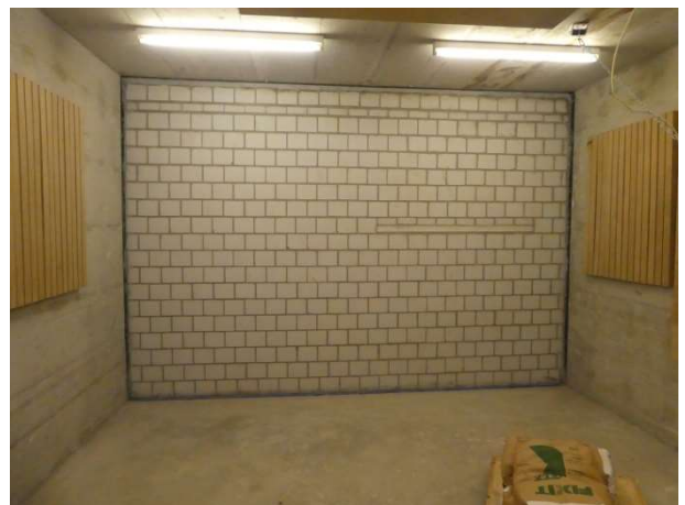
Abbildung 8: Ansicht der Wand vom Senderraum aus gesehen. Das Podest und der Lauf waren noch nicht eingebaut.
