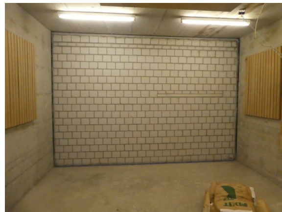
Abbildung 3: Ansicht der Wand vom Senderraum aus gesehen. Das Podest und der Lauf waren noch nicht eingebaut.
