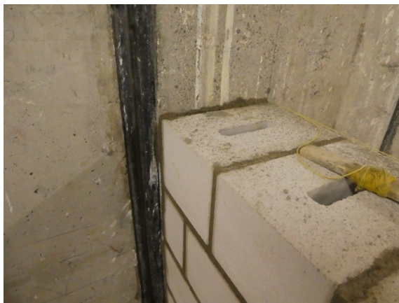
Abbildung 2: Detail des Mauerwerks.
