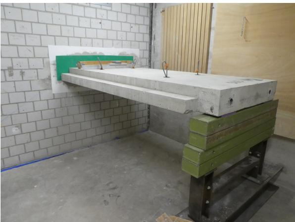
Abbildung 3: Podestlager eingebaut zwischen Treppenpodest und Wand, Sicht aus Senderraum.
