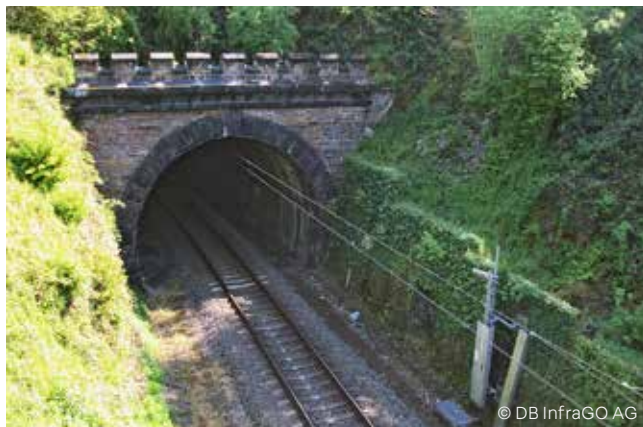
Horchheimer Tunnel, renowacja (Koblencja, Niemcy)
