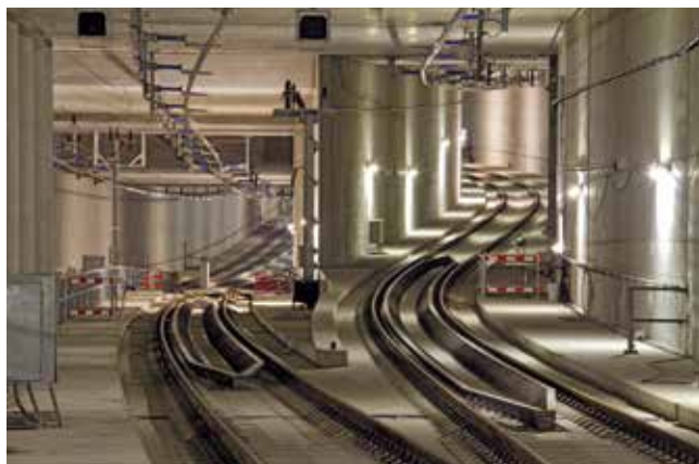
City-Tunnel (Lipsk, Niemcy)
