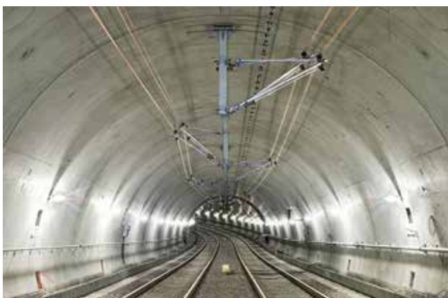
Przedłużenie linii kolei miejskiej U6 (Stuttgart, Niemcy)
