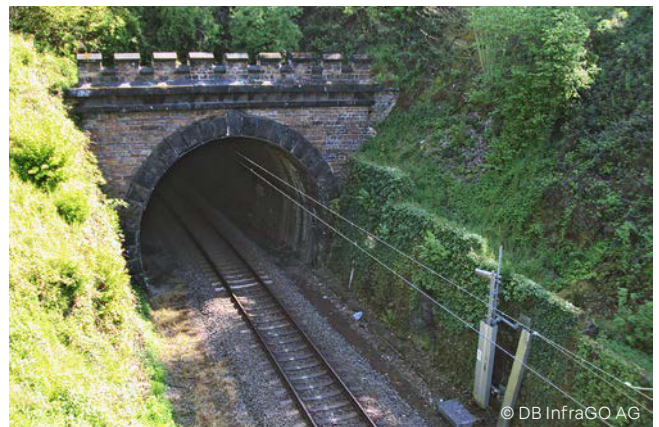
Horchheimský tunel, sanace (Koblenz, Německo)
